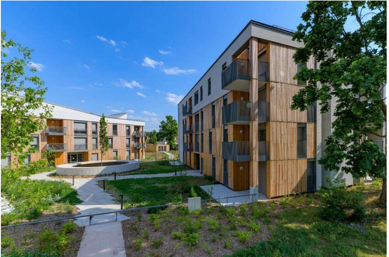
Résidence Arc-en-Ciel Le Vésinet (Les Yvelines 78) Construction neuve de 50 logements locatifs sociaux
