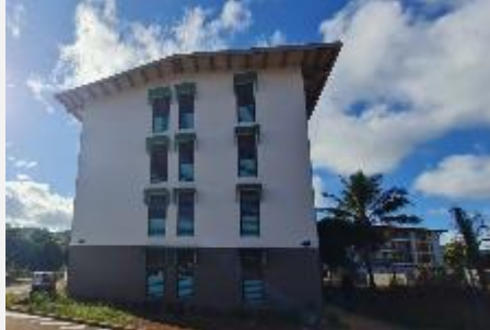
Résidence Miboukini 92 logements sociaux Combani – Mayotte
