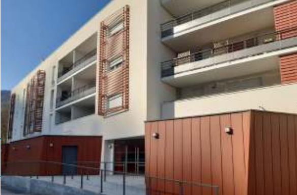
Résidence Osmose à Gières (38), 9 logements intermédiaires livrés en 2021.
