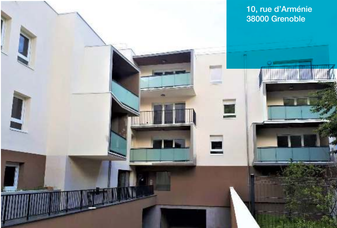
Résidence l'Aristide à Villard-Bonnot (38) 27 logements intermédiaires et 17 logements sociaux livrés en 2021.
