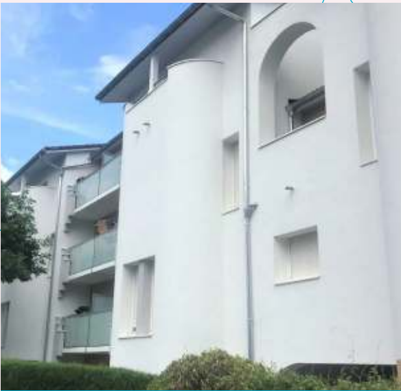
Réhabilitation de la résidence Rochepleine à Saint-Egrève (38), 66 logements. Livraison juin 2021.
