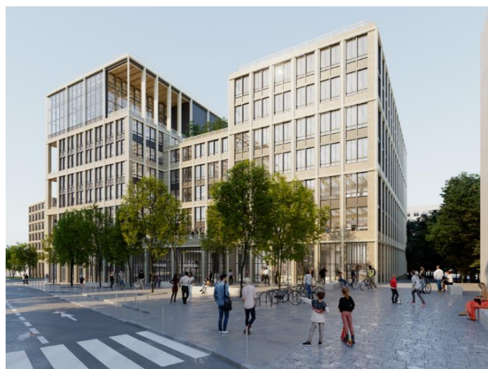
Lot E3 – Immeuble de bureaux
