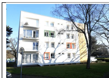
Résidence Roger Poulin Après réhabilitation (80 logements) Fin des travaux en 2020 (Travaux terminés)
