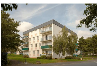
Résidence Marignan Avant réhabilitation (96 logements) Travaux en cours Fin des travaux 3 ème trimestre 2021
