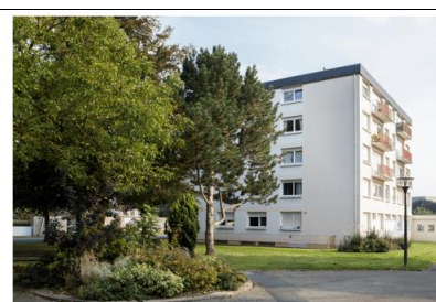
Résidence Abbé Lucas Avant réhabilitation (106 logements) Travaux en cours Fin des travaux 4 ème trimestre 2021
