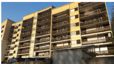
Valvert 2 – avant réhabilitation
