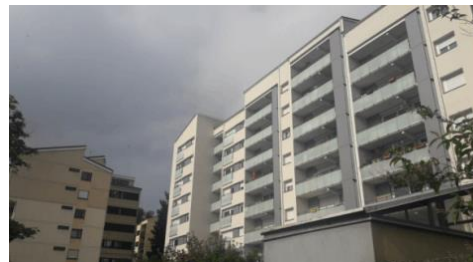
Valvert 2 – après réhabilitation
