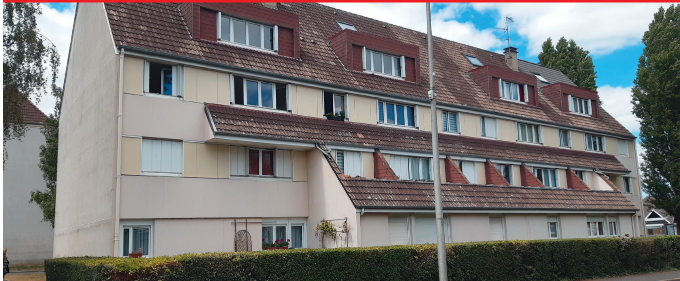
Résidence Épinette avant travaux
