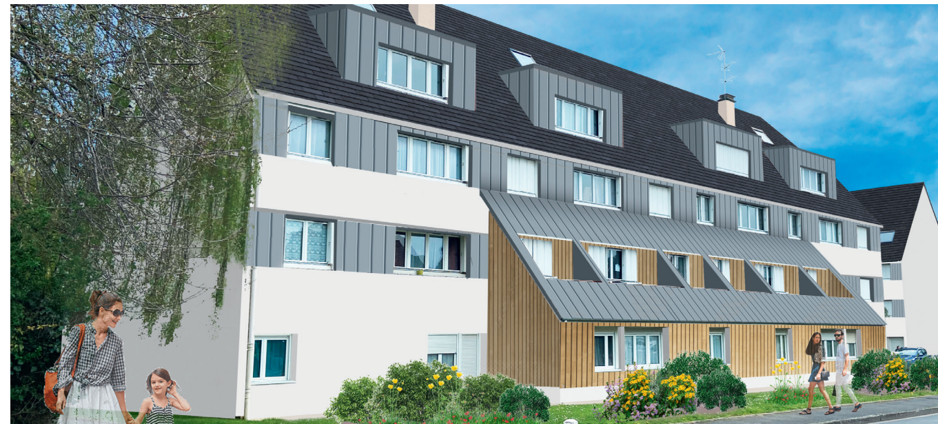
Résidence Épinette après travaux
