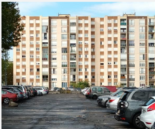
Copropriétés Quartier Sauveteurs- Cervelières – Vaulx-en-Velin (69) 60 logements
