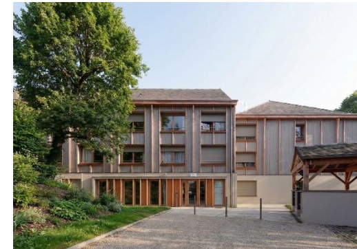
Résidence Bois Robert – Versailles (78) – 175 logements Architecte : PETITDIDIERPRIoux
