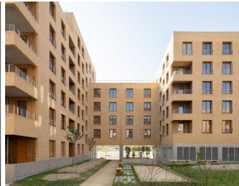
Pension de famille Mellinet – Nantes (44) – 25 logements Architectes : Jean et Aline HARARI
