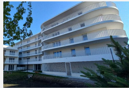
Résidence Ceiba – Le Bouscat (33) 30 logements sociaux
