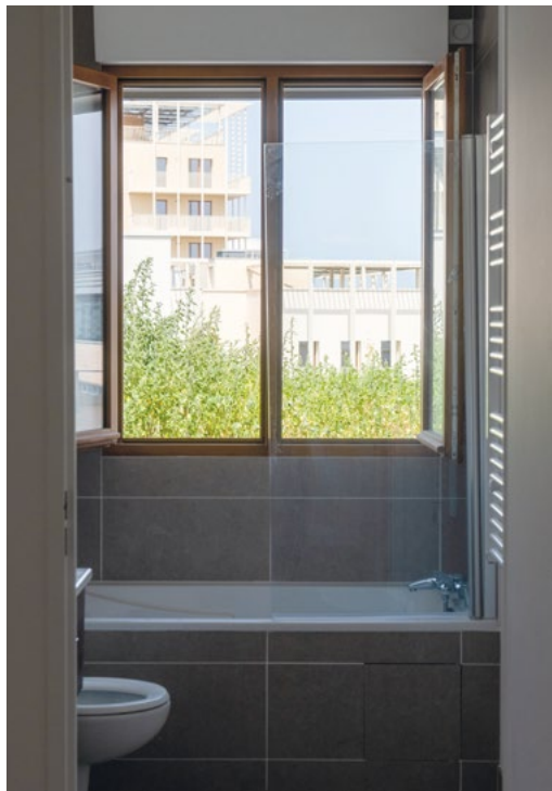
Un baignoire installée à la place d'une douche
