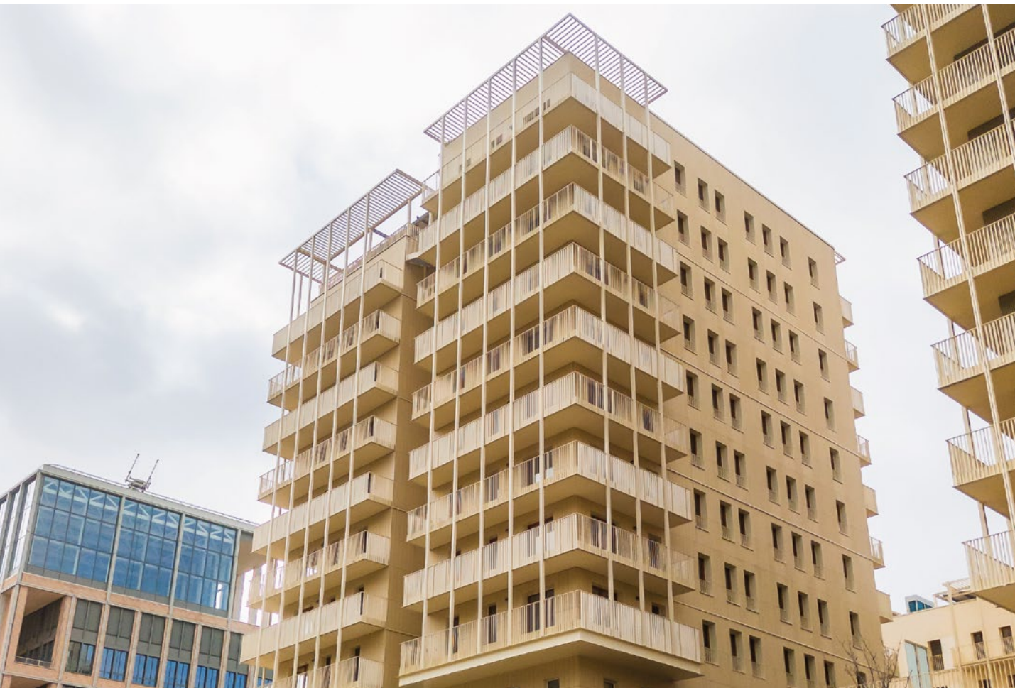
L'immeuble de coliving
