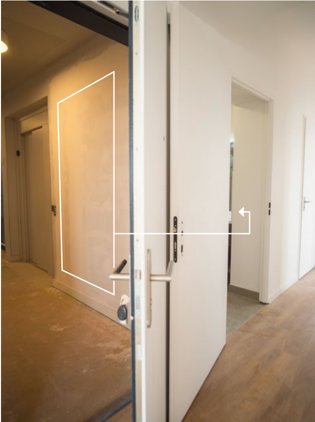
Une salle de bain créée dans le volume de la cage d'ascenseur retirée
