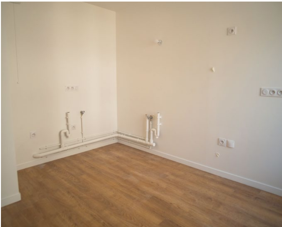
Un réseau de raccordement d'une cuisine en cours de travaux dans une ancienne chambre d'athlète
