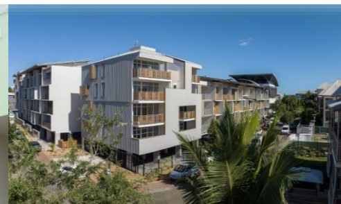
Résidence Constellation La Possession (Réunion) 71 logements dont 19 logements sociaux et 52 logements intermédiaires
